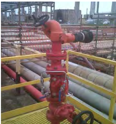
ГИДРАВЛИЧЕСКИЙ КОНТРОЛЬНЫЙ КЛАПАН
