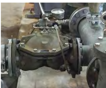
СБРОСНОЙ КЛАПАН НА СИСТЕМЕ ПОЖАРОТУШЕНИЯ МОРСКОЙ ВОДОЙ
